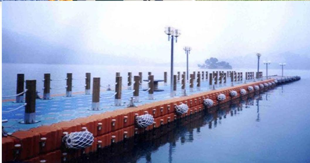
Наплавной мост (переправа) должен иметь ширину не менее 5 метров и иметь крепления к берегу и якорям. Расстояние между якорями не должно превышать более 10 метров.
