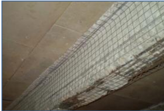
Усиление железобетонной обоймой
