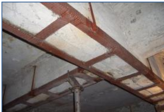
Усиление металлическим профилем
