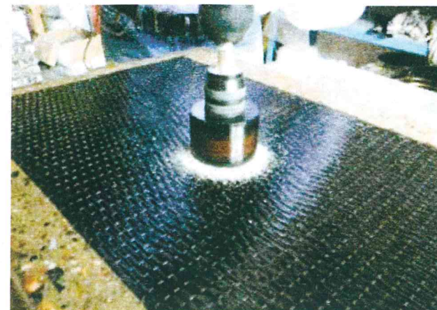
Рисунок Д.6 – Обуривание СВА вокруг «пятачка»
