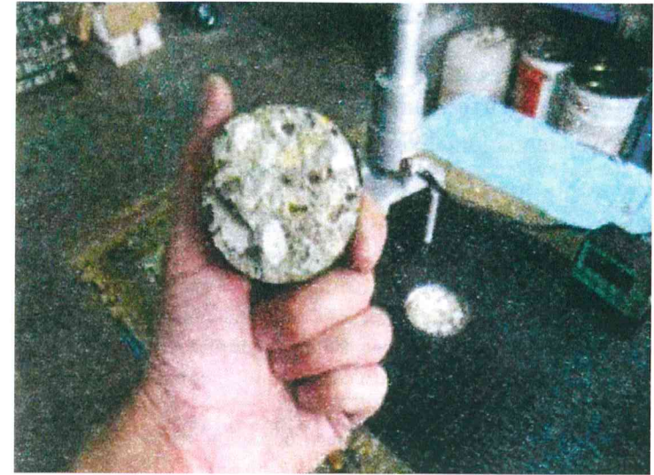
Рисунок Д.10 – Когезионное разрушение бетонной подложки
