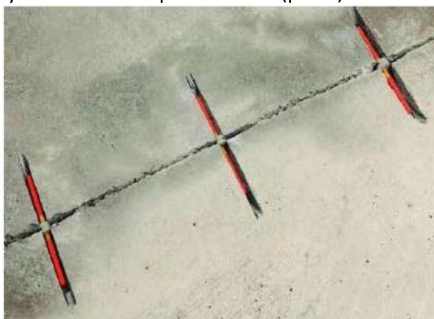
Рисунок 7. Установка стяжек в каналы, открытые в трещинах
