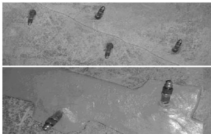
Рисунок 5. Пакеры, установленные вокруг трещины и загерметизированные эпоксидным клеем
